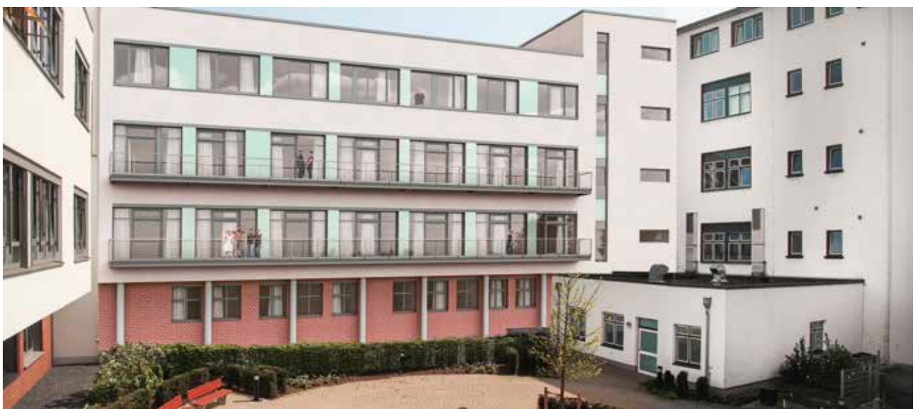
Künftige Ansicht des Westflügels (Innenhof) mit Intensivstation (obere Etage) sowie Bettenstationen für Geriatrie (2. OG) und Chirurgie (1. OG)
